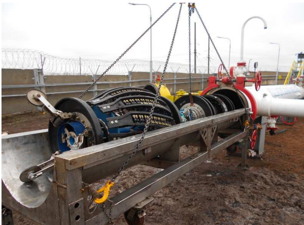
Рис.5.4 Подготовка трубопровода к диагностике состояния
